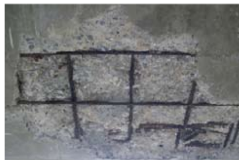
■鉄筋の腐食
